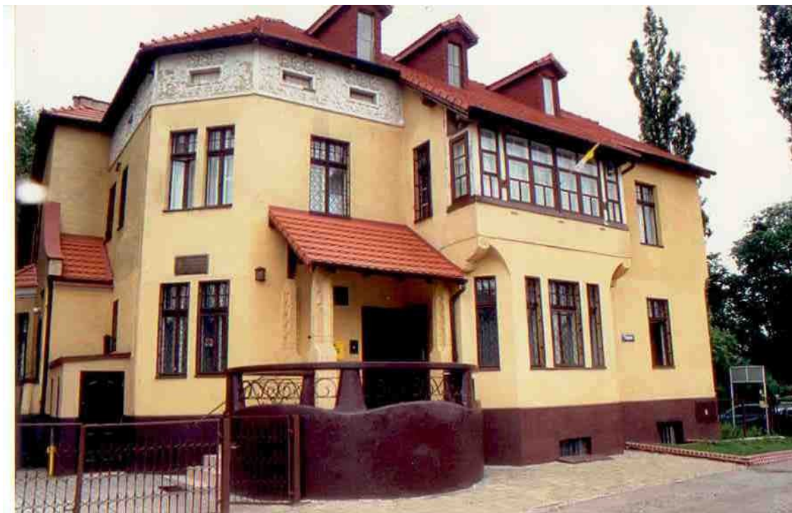
Fot. : Budynek KPOIL przy ul. Chopina 20, w którym w latach 1990-2013 mieścił się Oddział GBL w Toruniu
